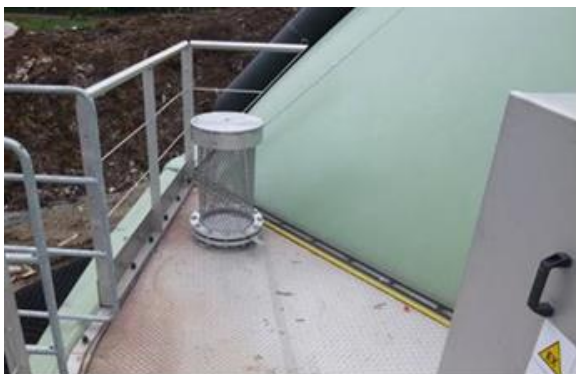
Figure 1. Illustration et schéma du disque de rupture- BTS Biogaz.
